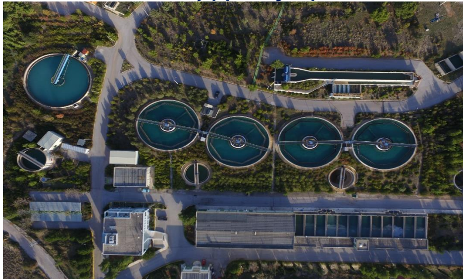
Μονάδα Επεξεργασίας Νερού Ασπροπύργου
