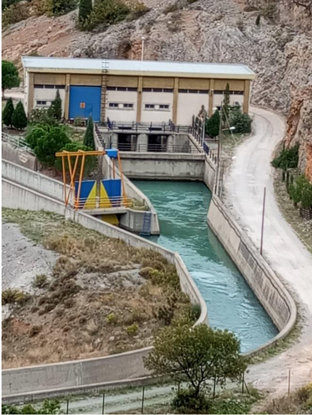
Άποψη έργου Καταστροφής Ενέργειας (ΕΚΕ)
