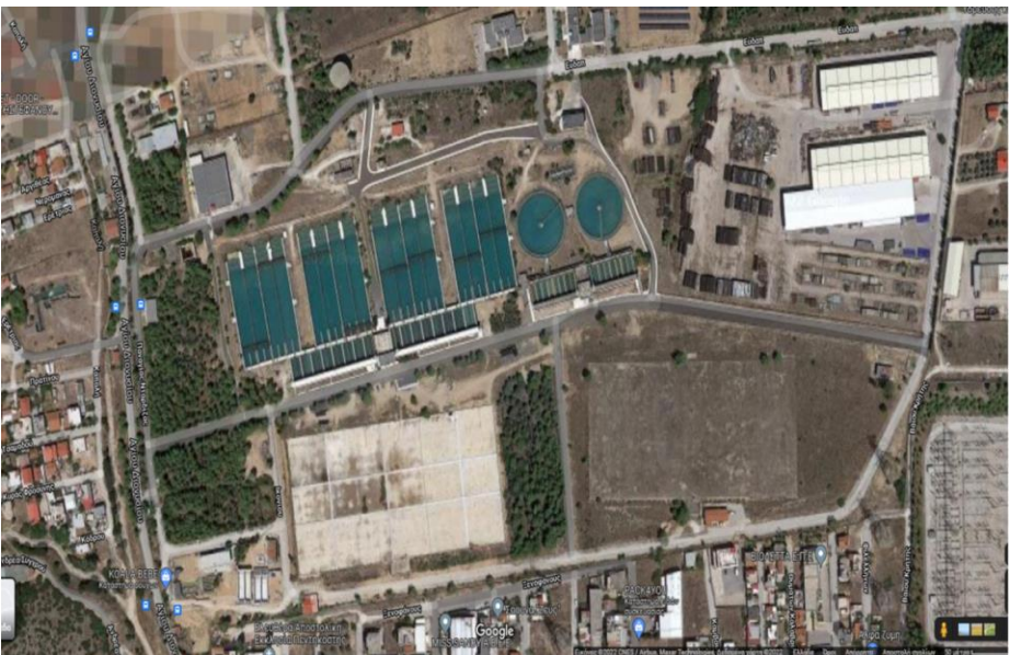
Μονάδα Επεξεργασίας Νερού Αχαρνών
