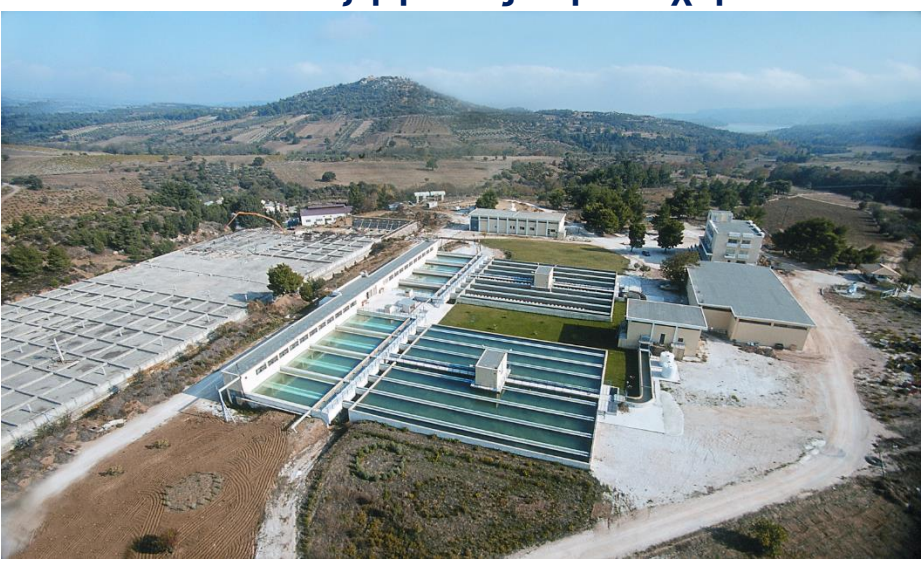
Μονάδα Επεξεργασίας Νερού Πολυδενδρίου
