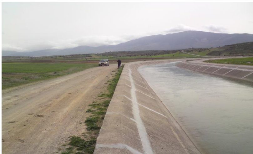
Υδραγωγείο Μόρνου – Διώρυγα Θηβών
