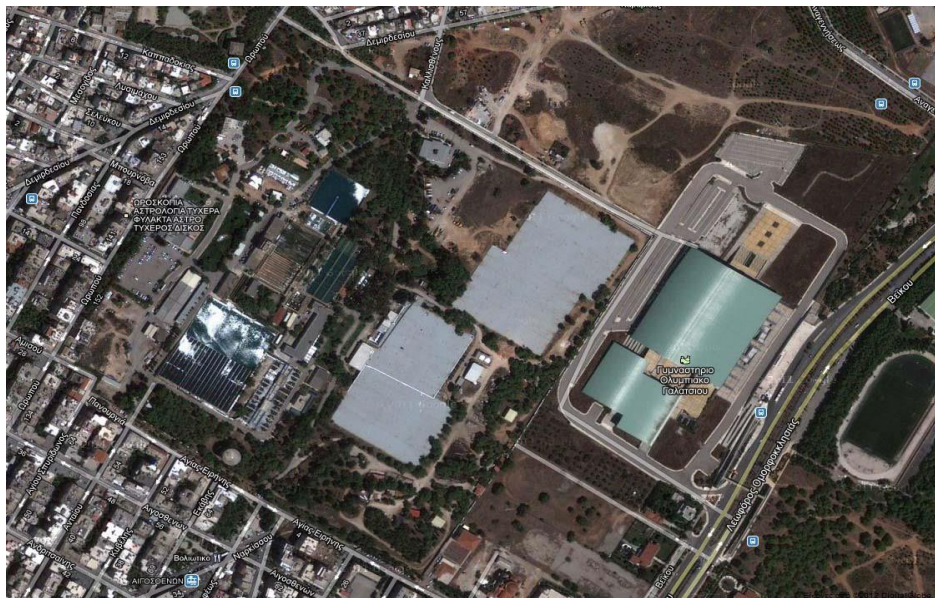
Μονάδα Επεξεργασίας Νερού Γαλατσίου
